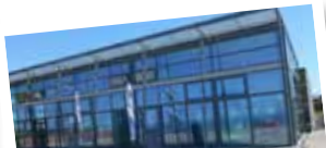
LE TRÉPORT - FUNICULAIRE 76470 Rue du Télécabine Gare Haute du Funiculaire Boulevard du Calvaire
